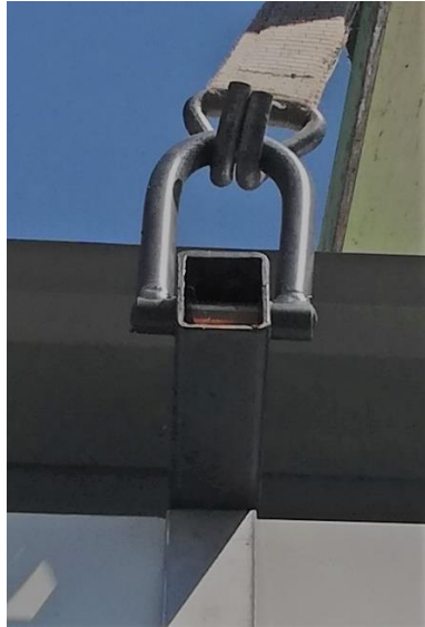
Rys. 12 Punkt zaczepienia pasa na platformie auta transportującego chłodnię.
