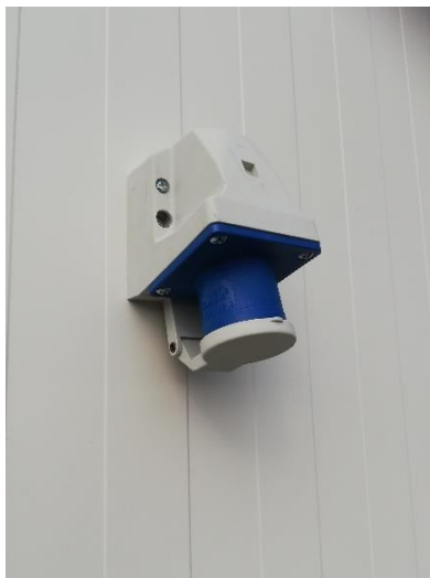
Rys. 17 Gniazdo PCE IP44
