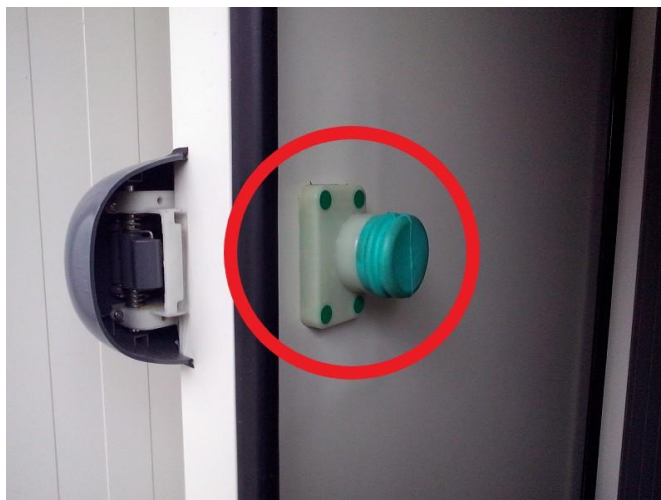
Rys. 8 Zawór bezpieczeństwa zintegrowany z zamkiem
